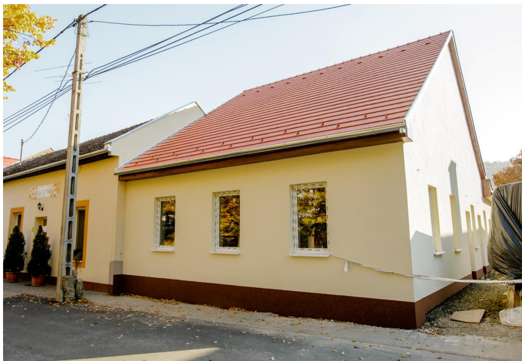
Kemencei mosodaépület építése 2021 végén
